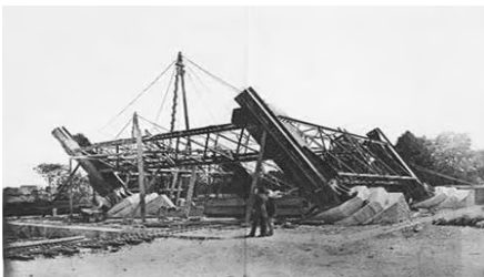
Montage de la 4 e pile de soutien.
